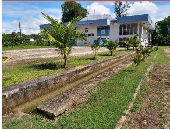
Foto 1 – Identificação do canal de drenagem na lateral do prédio da Faculdade de Engenharia Naval.
