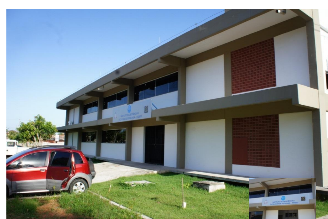
Figura 5 – vista diagonal do novo Laboratório de Geologia-Ensino da Faculdade de Geologia da UFPA; abaixo a direita, detalhe da fachada. Imagem Fernando Pina.
