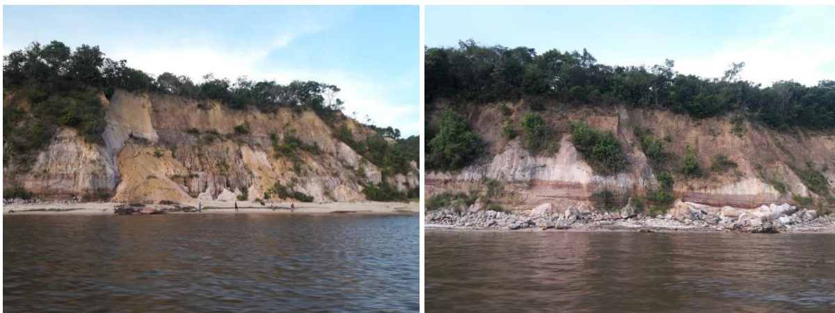
Figura 9 - Escorregamentos em área de encosta da cidade de Óbidos
