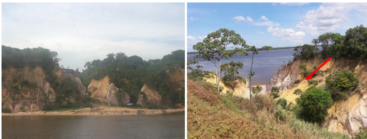
Figura 12 – Feição erosiva do tipo Voçoroca, localizada no bairro Santa Terezinha Fotos: Joselito Lima (2018)
