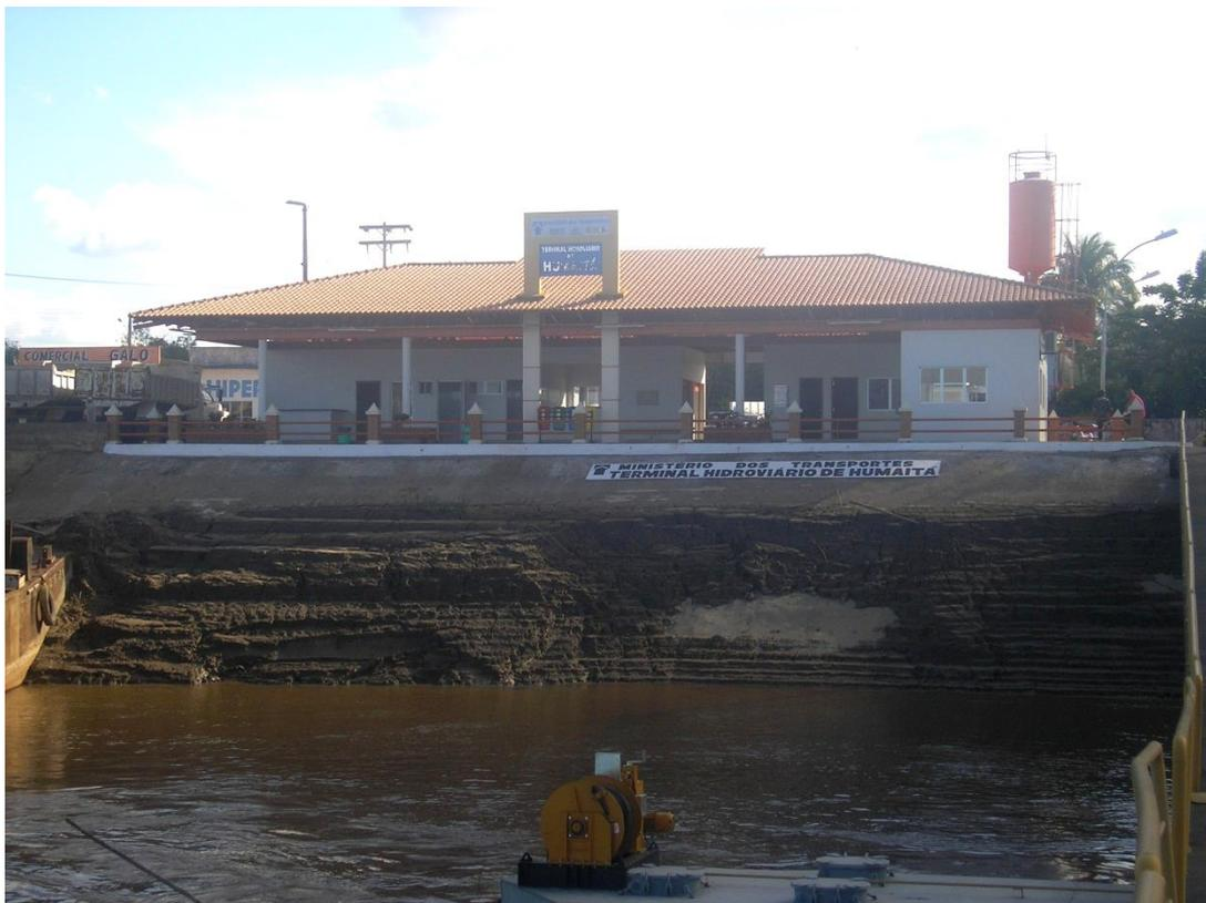
Figura 19: Acúmulo de sedimentos no talude.
