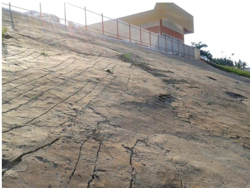
Figura 21: Trincas no talude.
