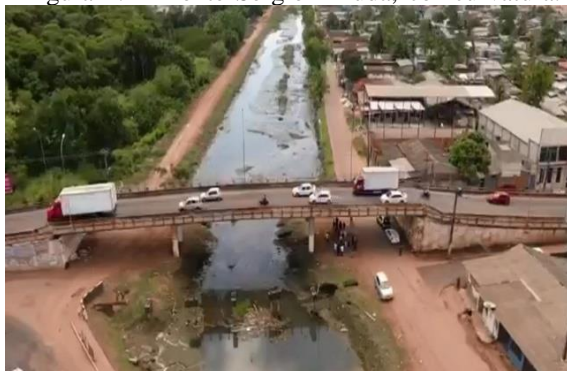
Figura 4: 1ª Ponte Sérgio Arruda, com curvatura.
