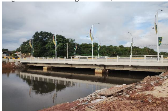
Figura 5: 2ª Ponte Sérgio Arruda, ao nível do solo.
