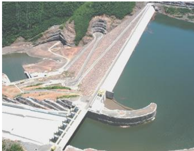
Figura 9: - Barragem de enrocamento da usina hidrelétrica de Barra Grande
