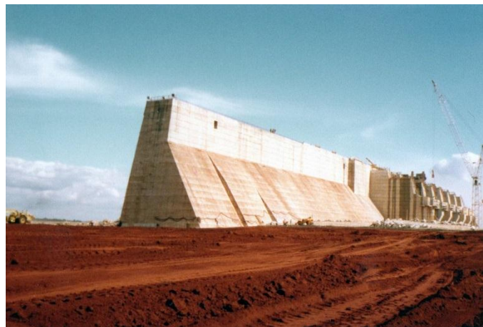
Figura 7: - Barragem tipo gravidade da usina hidrelétrica de Itumbiara Fonte: FLICKR
