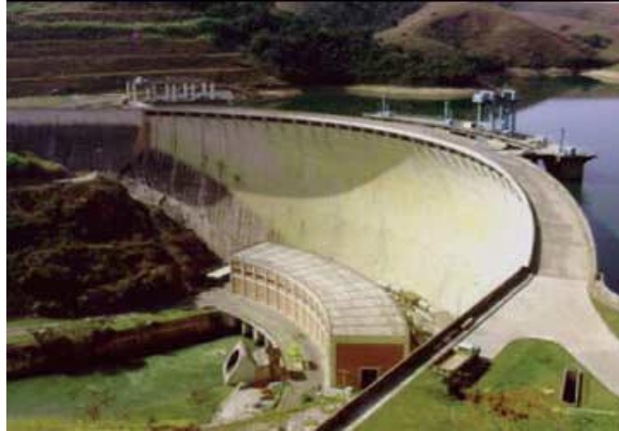
Figura 6: - Modelo de barragem de concreto do tipo abóbada Fonte: FURNAS CENTRAIS ELÉTRICAS.
