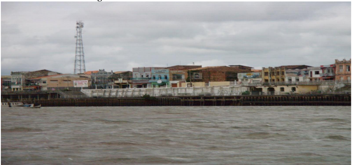
Figura 2 - Foto da frente da cidade de Cametá
